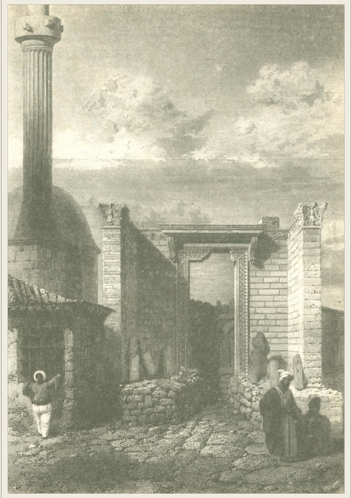
Augustus Tapınağı ve Hacı Bayram Camii
