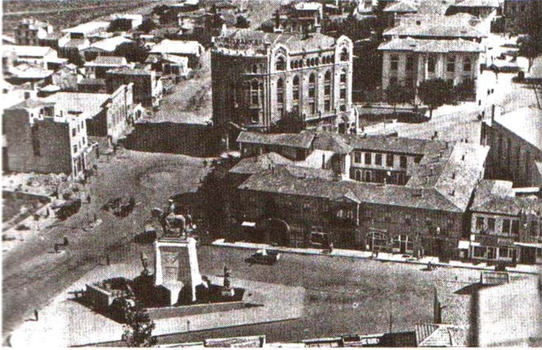
1931'de Ulus Meydanı. Fotoğraftaki binalardan günümüze sadece İş Bankası kalmıştır. Sağında görülen Taşhan'ın yerine birkaç yıl sonra Sümerbank genel müdürlüğü inşa edilmiş ve anıtın yeri değiştirilmiştir.
