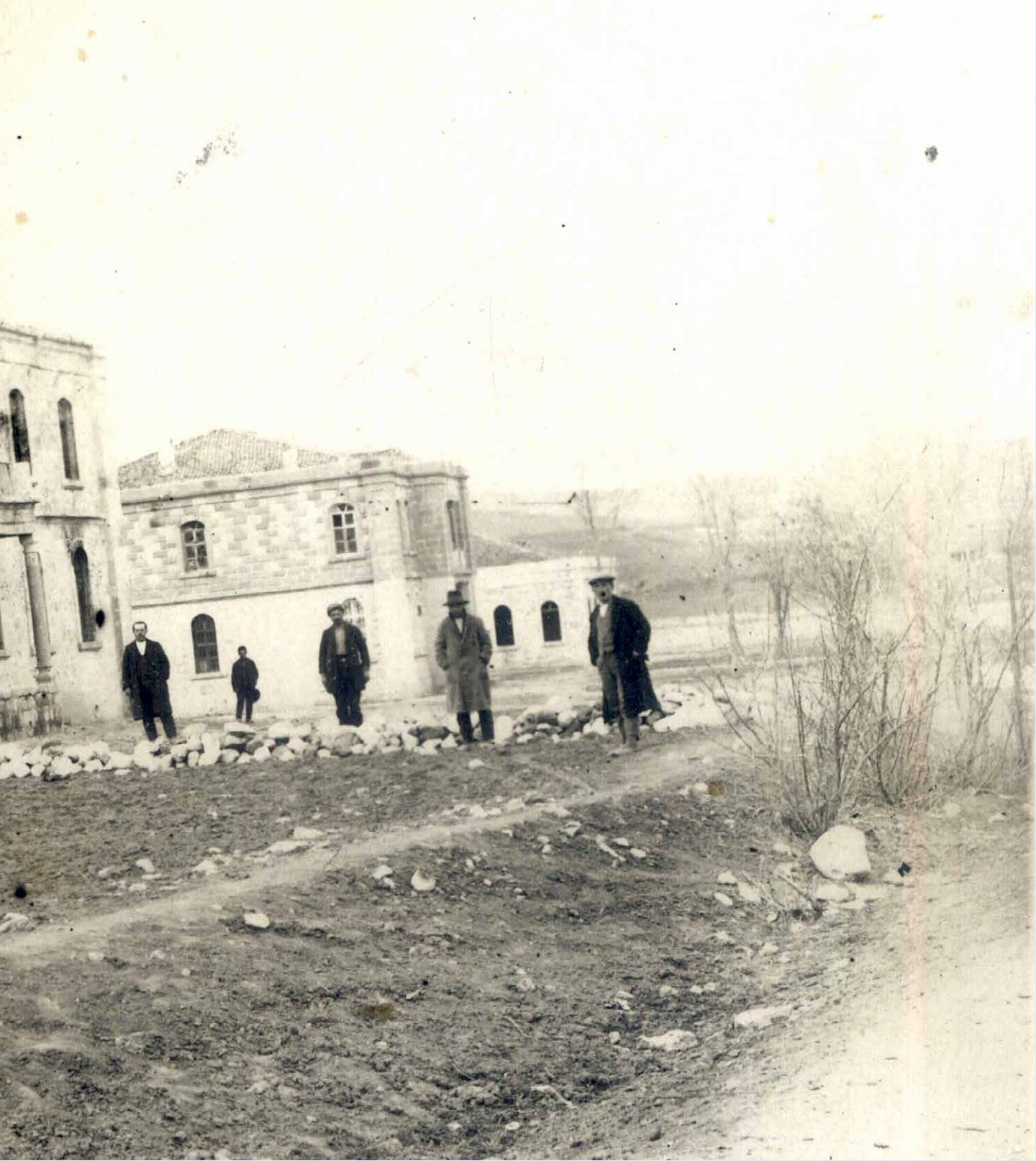
Kalecikte İnşa Edilen Askeri Bina, Cephanelik ve Depo
